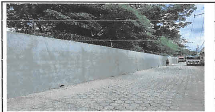
FOTO 3: se levantará y se reforzará el muro perimetral
