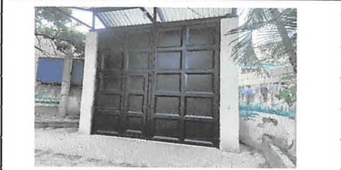
FOTO 7: SE REALIZARAN 2 COLUMNAS Y SE LEVANTARAN 2 PAREDES PARA MOVER EL PORTÓN HACIA ADETRÁS
