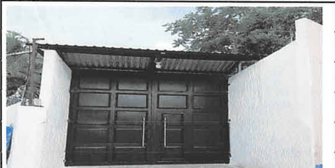
FOTO 9: SE CABIARÁ EL PORTÓN PRINCIPAL YA QUE SE ENCUENTRA DETERIORADO
