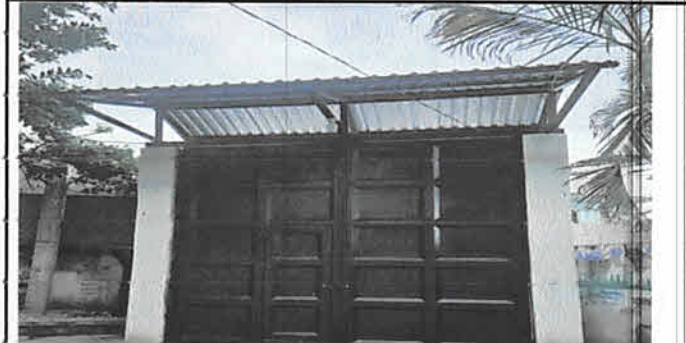
FOTO 8: SE COLOCARÁ TECHO SOBRE EL PORTÓN DE LA ENTRADA PRINCIPAL
