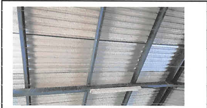
FOTO1: SE REALIZARÁ EL CAMBIO DE UNA LAMINA EN AULA
