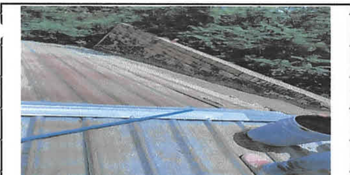
FOTO 11: SE REMOVIO BORDILLO EN LAMINA DE TECHO Y APLICO NUEVO BORDILLO
